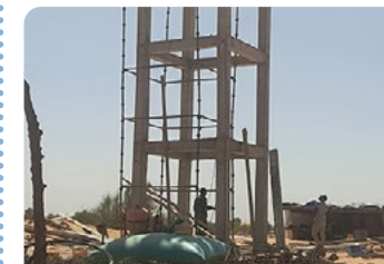
Les travaux de construction à Jidrel Mohguen
